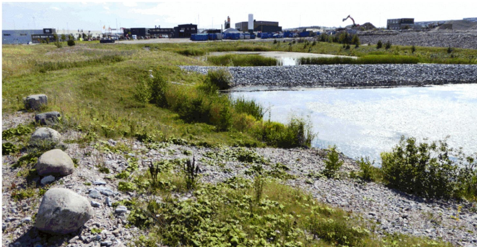
Figur 15 Avskiljare mellan fördamm och huvuddamm (VA-guiden, u.d.).
