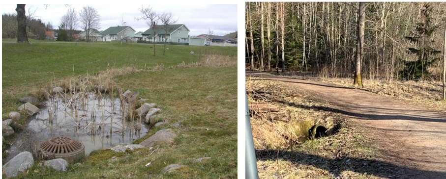
Figur 18 Tv. Exempel på förhöjt utlopp via kupolbrunn (Sweco). T.h. Befintlig trumma under den norra stig belägen vid utlopp från dammen (Sweco).
