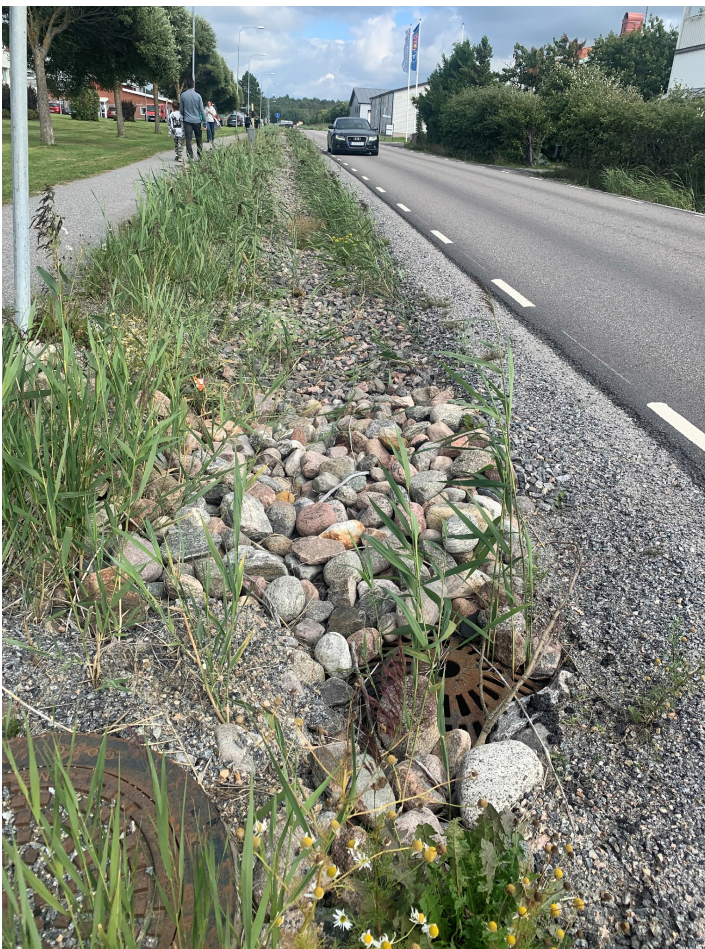
Figur 13 Exempel på makadamfyllt dike längst med väg (Sweco).
