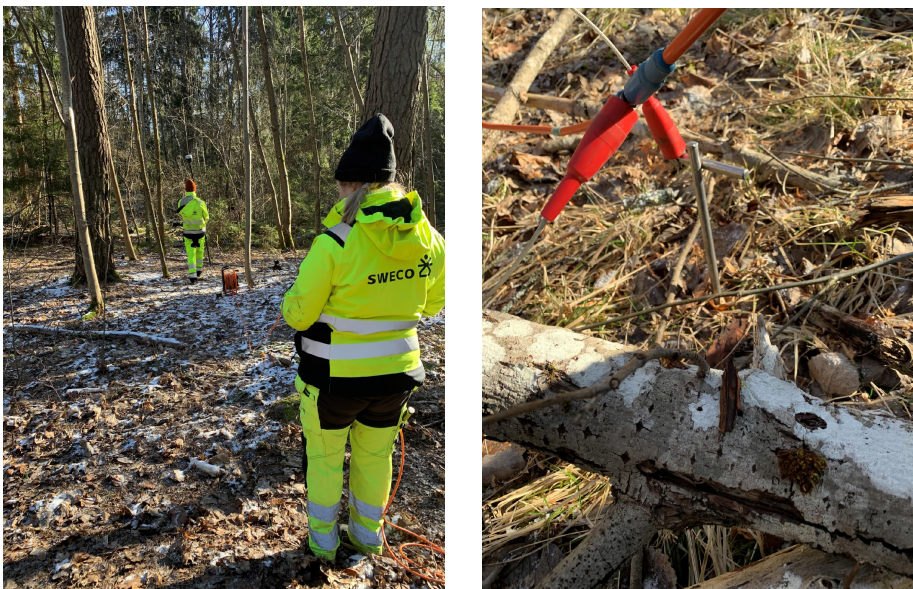
Figur 2 Bilder från mätning av nivå till berg (Sweco).
