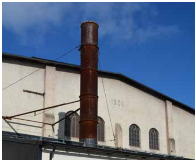
Martinverkets karaktäristiska fasad mot älven.
