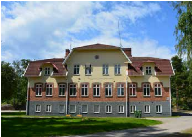
Byggnad som tidigare användes som kontor.
