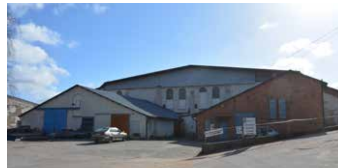
Martinverket med tillbyggnader (nu rivna).
