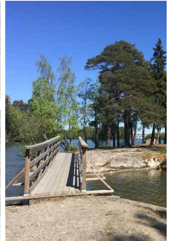
Befintlig bro ut till en liten ö
