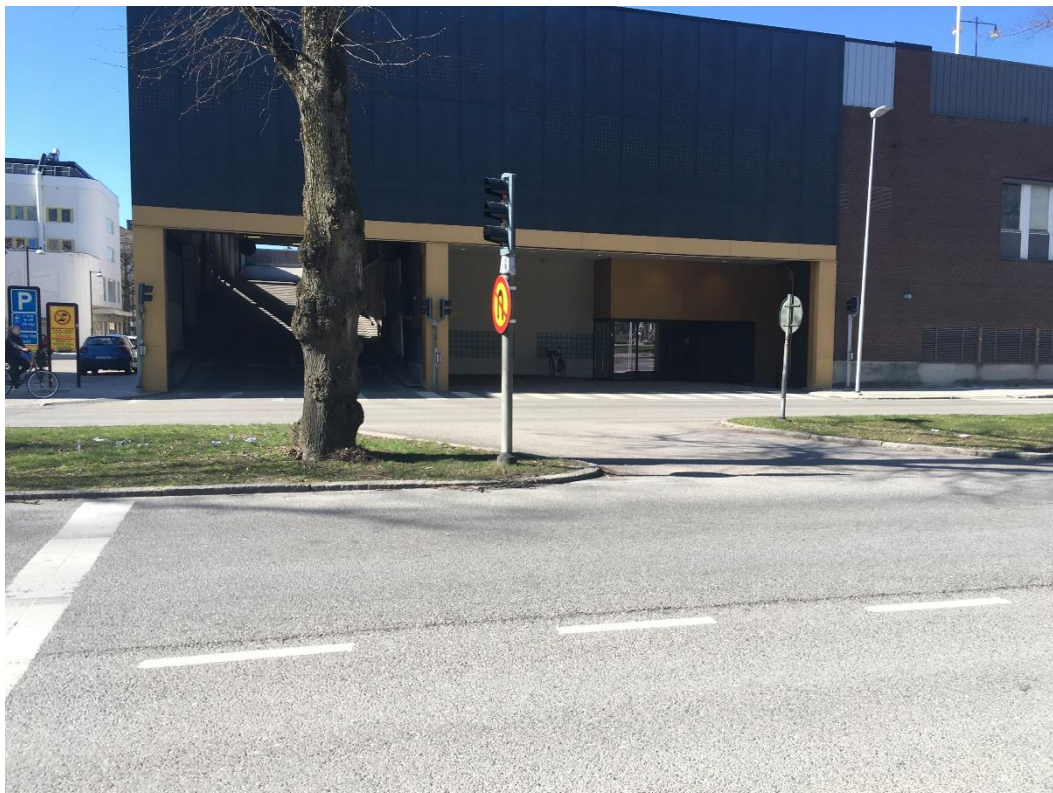
Figur 11. Gångbana mellan Magasinsgatan (till vänster) och passagen över Drottninggatan (till höger). Här finns dubbla utfarter från parkeringshuset, utfart för leveransfordon till Oden samt en entré för besökare till Oden.
