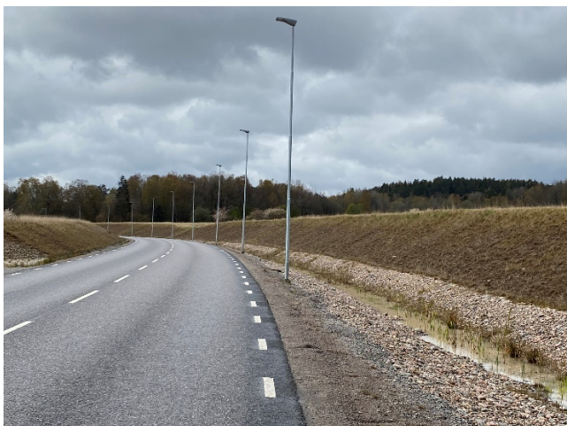
Överbyvägen, nedgrävd i ett schakt
