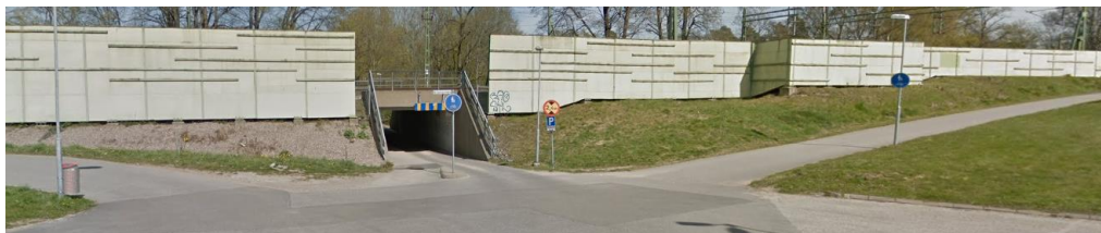
Figur 22 Befintlig Gc-port under järnvägen vid Storgatan/Parkstigen. Källa: Google Maps (2017)
