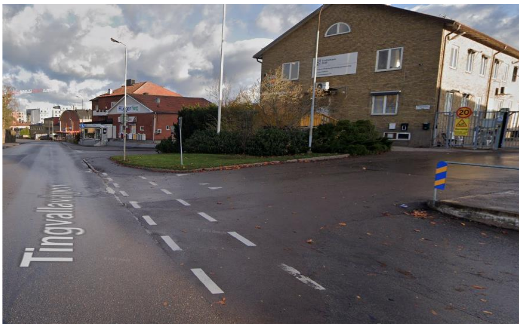
Figur 27 - Gång- och cykelbana längs Tingvallavägen som redan idag korsar en in- och utfart vid befintlig verksamhet vid kvarteret Grävlingen. Källa: Google maps 2021.
