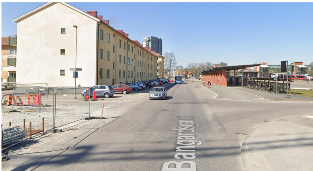
Figur 7 - Korsningen Dicksongatan/Bergslagstorget, vy från sydost. Källa: Google Maps 2019
