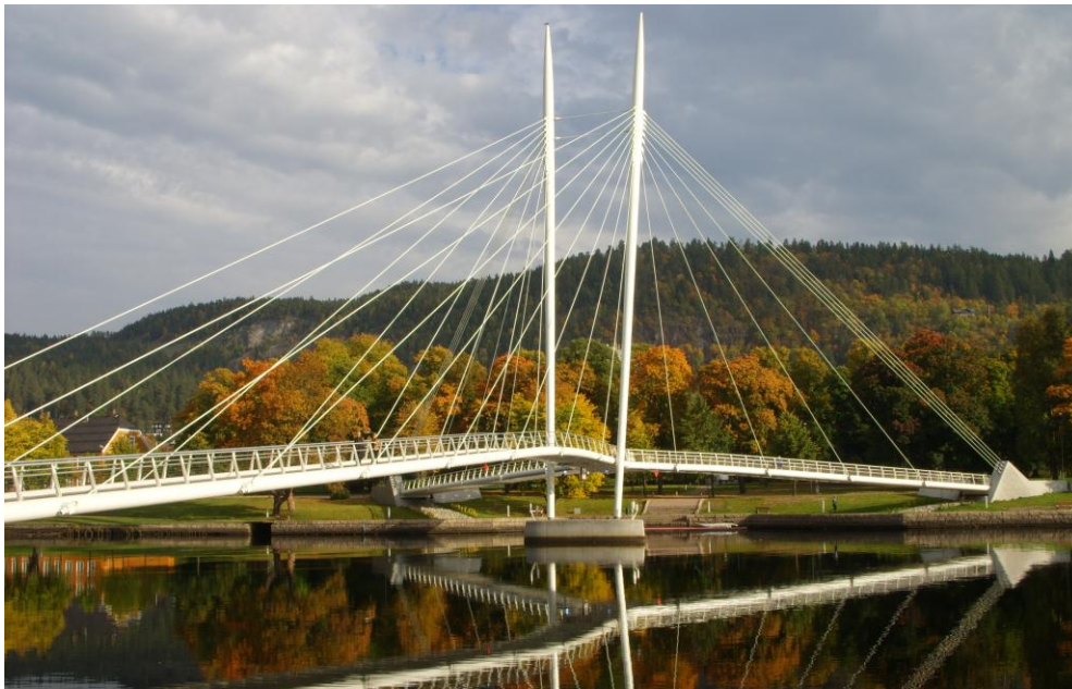
Figur3.5: Ypsilonbron i Drammen, Norge. Exempel på hur en gång- och cykelbro kan se ut (med reservation för att denna bro inte är öppningsbar).
