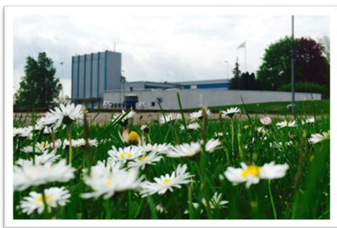
Vattenverket vid Överby.
