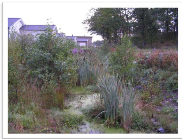
Födröjningsanläggning för dagvatten i Strömslund.
