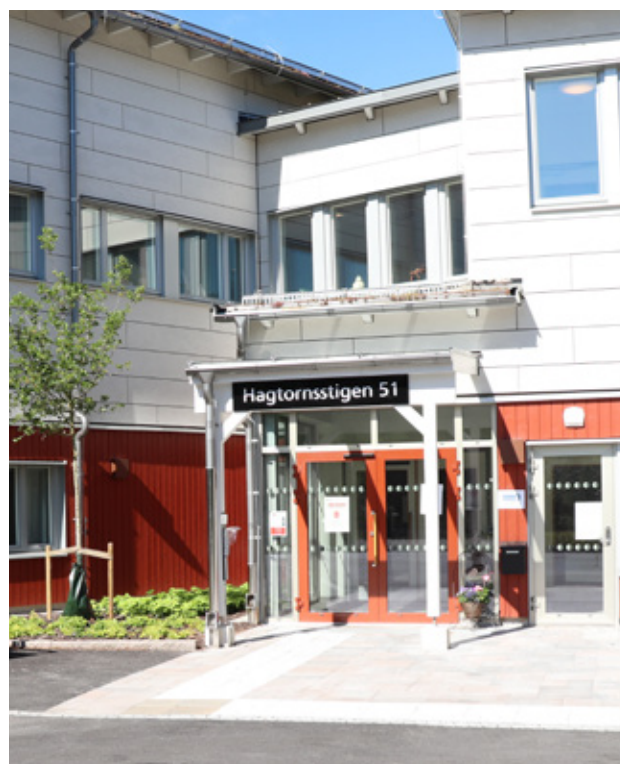
Inflyttningen startade på det nya vård och omsorgsboendet Hagtornsstigen 51.
